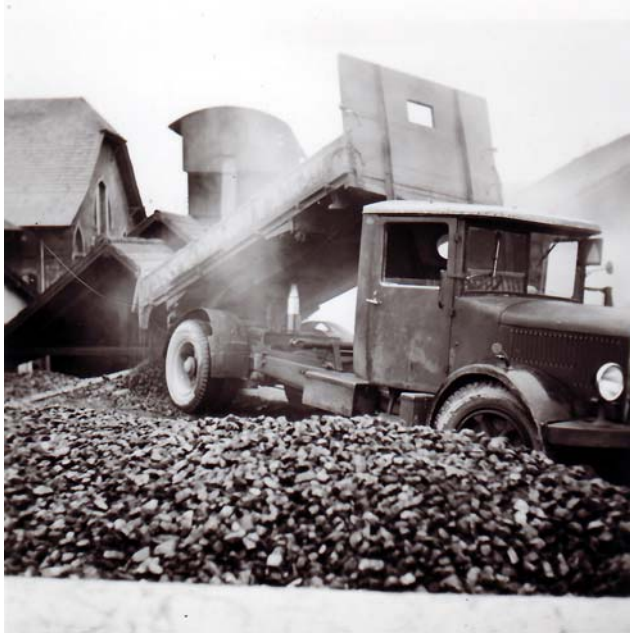
Gaswerk 1947: Koks und Kohle werden zugeführt.
